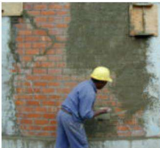
Ilustración 197. Pañeteo de la pared reparada
