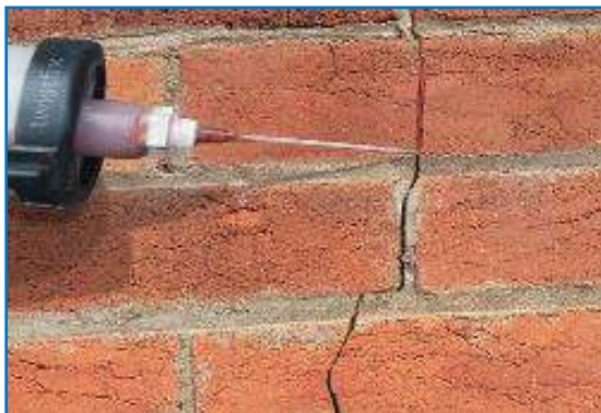
Ilustración 11. Unidad de albañilería artesanal
