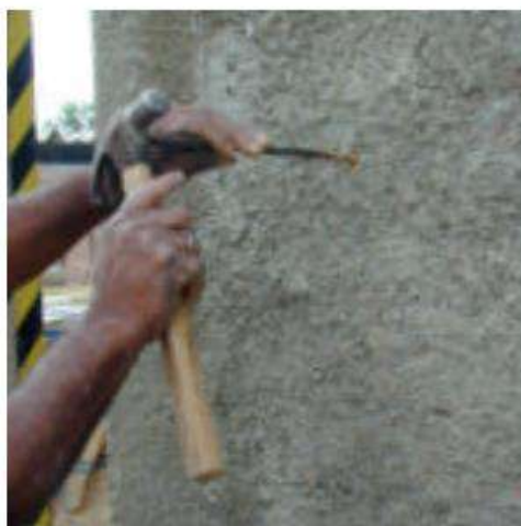
Ilustración 198. Perforación de la pared para colocación de mallas
