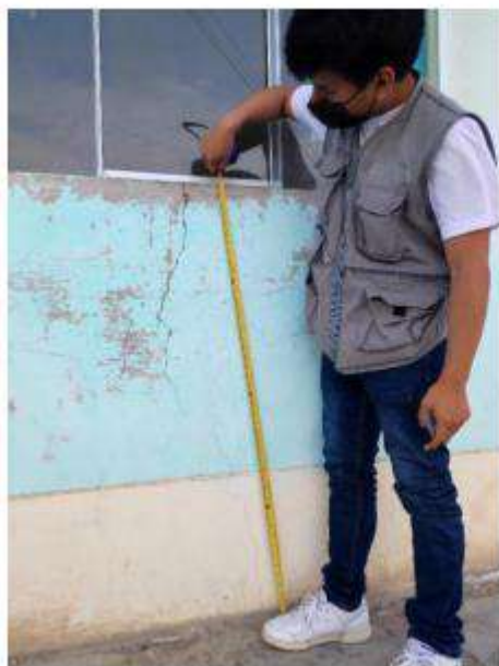
Foto No. 8: Recolección de datos en las áreas de los muros afectados por las fisuras y grietas
