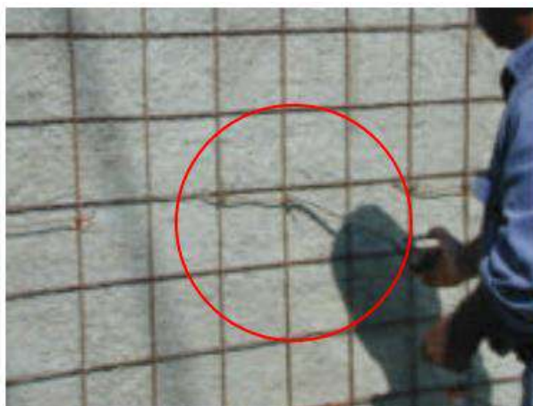
Ilustración 199. Enmallado de muros
