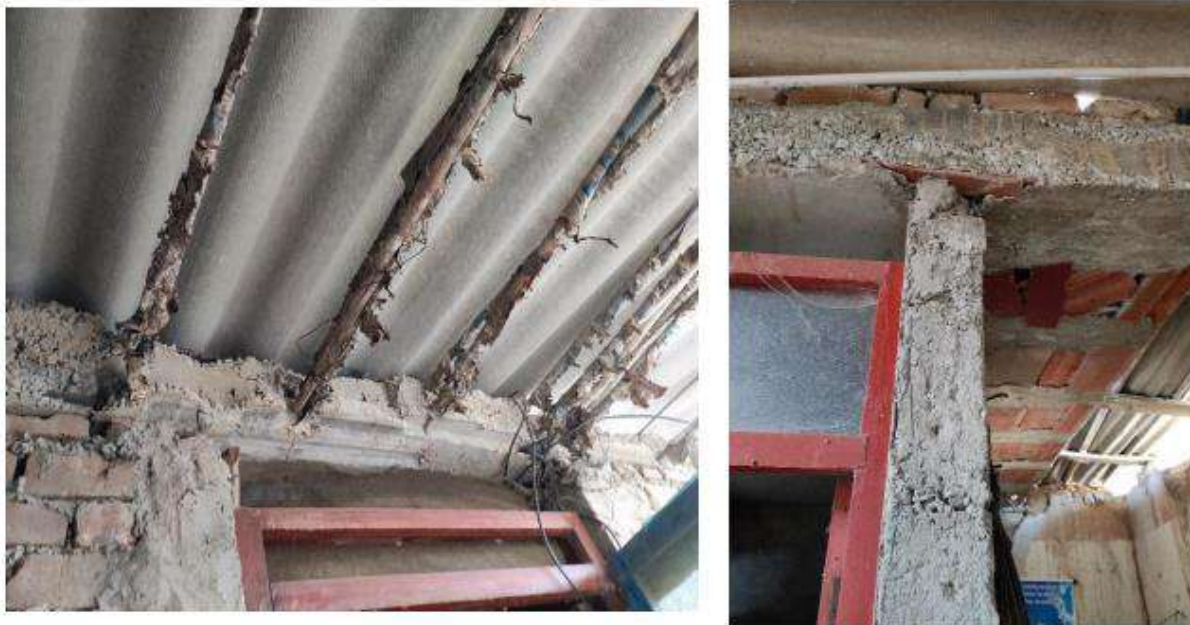
Foto No. 6: Recolección de datos en las áreas de las vigas y columnas afectadas por las cangrejas
