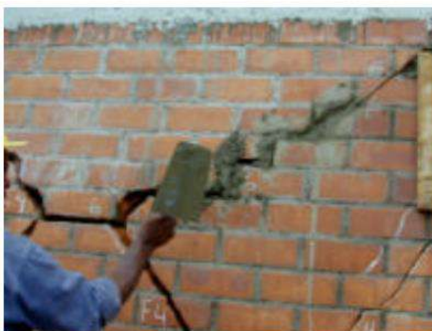
Ilustración 196. Colocación del mortero en las perforaciones
