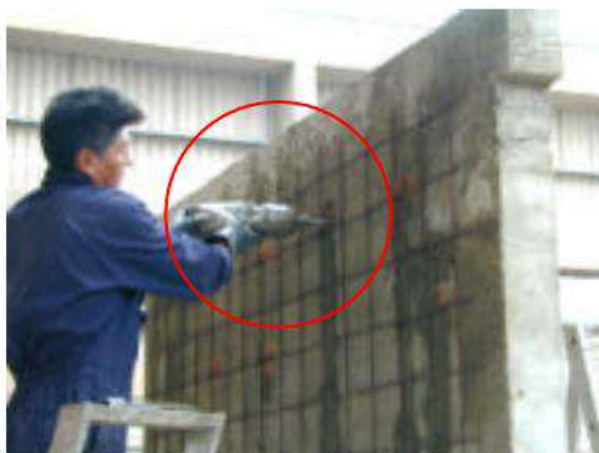
Ilustración 200. Colocación de la lechada de cemento
