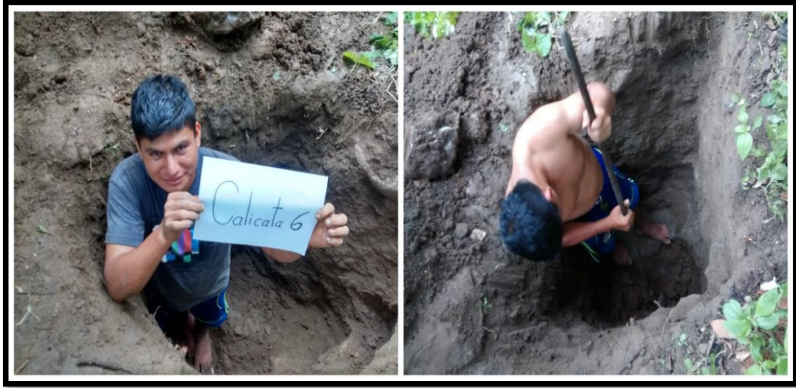
Fotografía 8.15: Excavación de calicata N° 6 y muestra de suelos a Km 3+000
