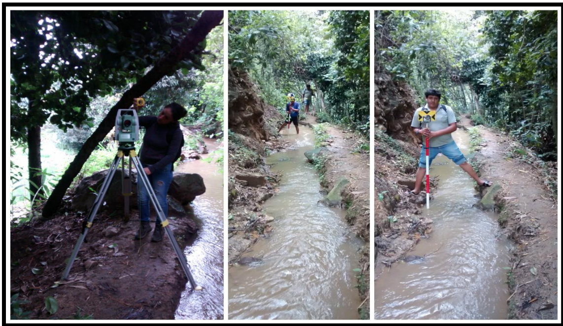
Fotografía 8.8: Tomando puntos del canal existente.
