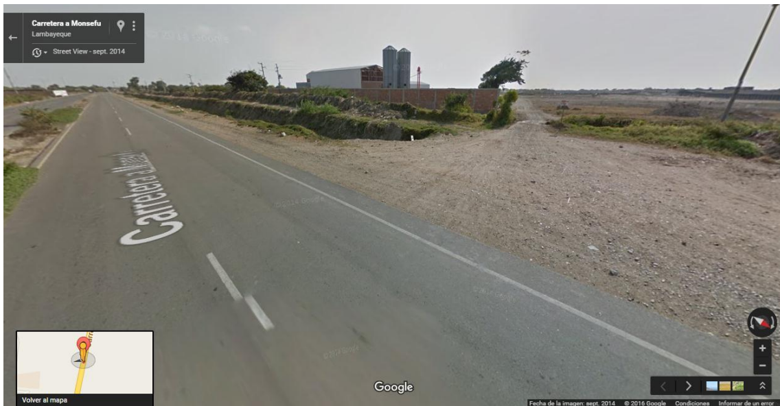
Figura N° 21: Ubicación de la Fábrica vista frontal
