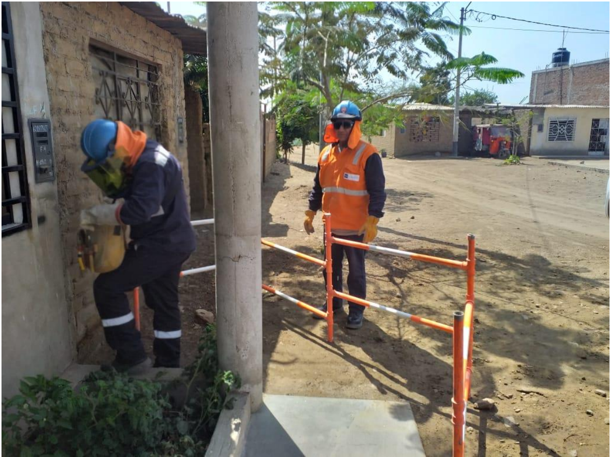
Figura 40: Personal técnico de averías iniciando atención de avería reportada
