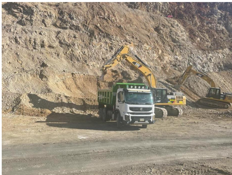
Ilustración 40: Carguío de material por excavadora.
