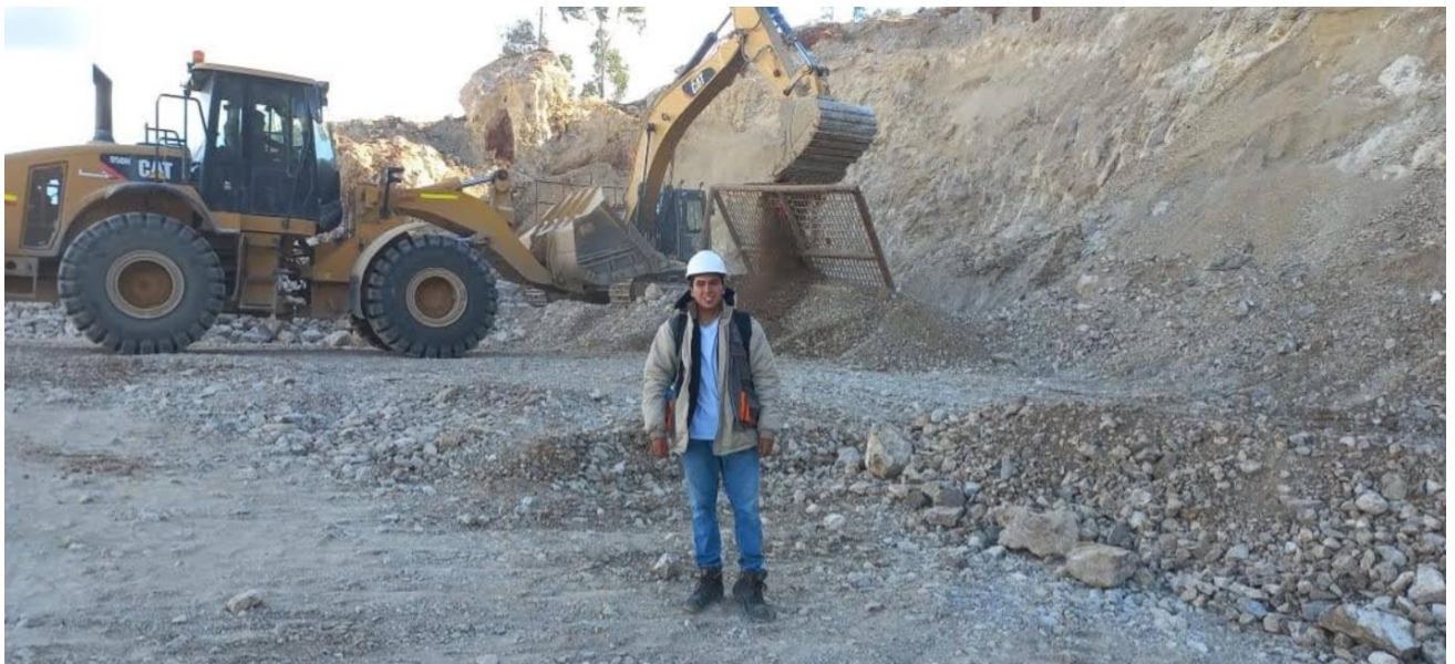
Ilustración 60: Cargador Frontal zarandeando material en cantera
