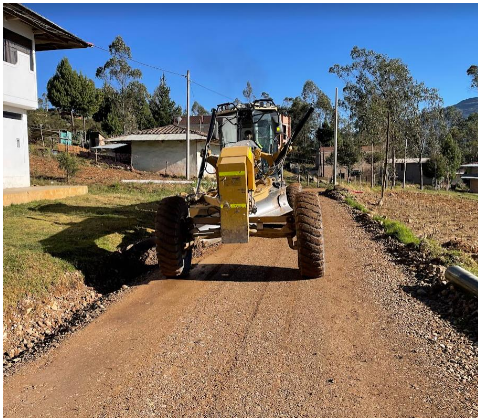
Ilustración 62: Perfilado y compactación de afirmado
