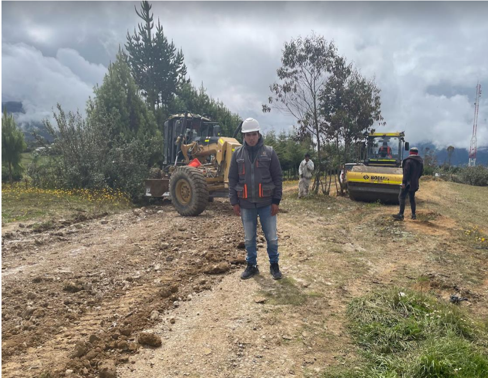
Ilustración 59: Cuadrilla N° 1, problemas mecánicos en rodillo
