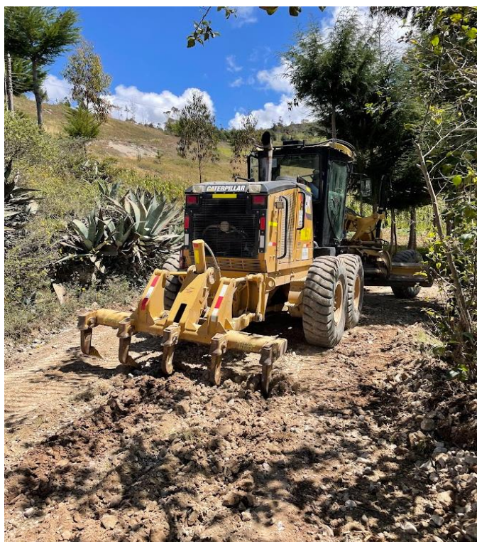
Ilustración 30: Corte a nivel de subrasante con Ripper de motoniveladora
