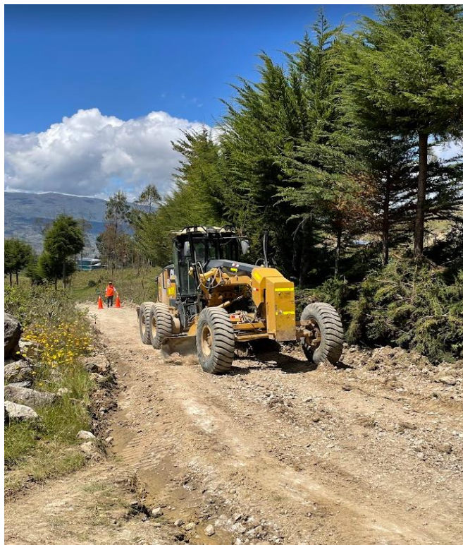
Ilustración 31: Extensión de material por motoniveladora
