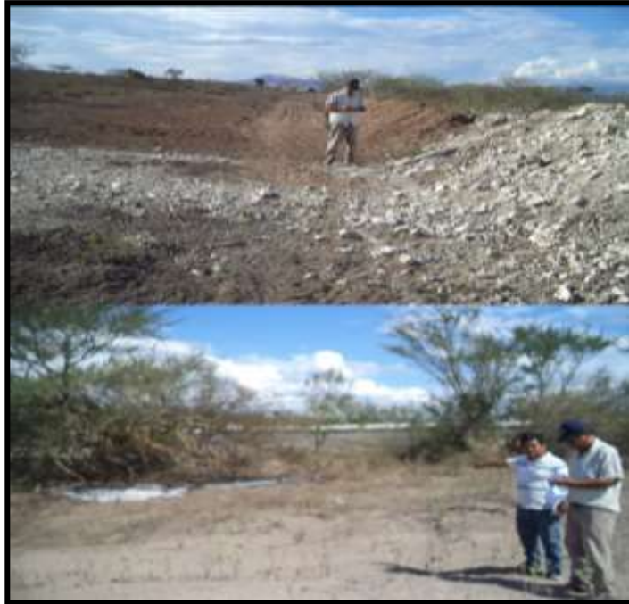
Figura 36. Preparación del terreno para el botadero controlado municipal
