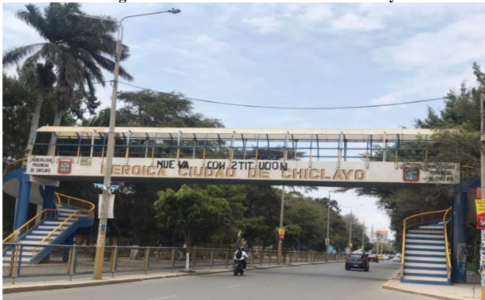
Imagen N° 34: Puente Peatonal Av. Salaverry
