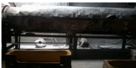
Figura 18. Reparación de recipientes que contienen el carbón de piedra.
