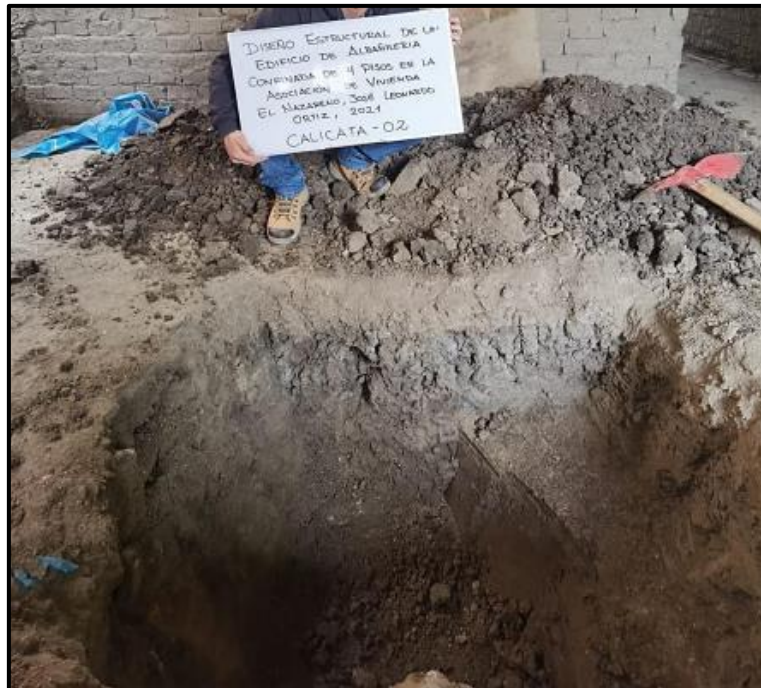
Imagen 54. Vista general del perfil estratigráfico de la calicata C-02 del estudio de mecánica de suelos
