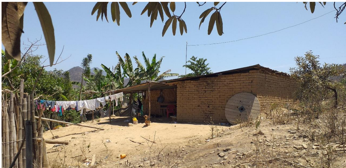
Figura 19. Fotografía de la vivienda N°01.
