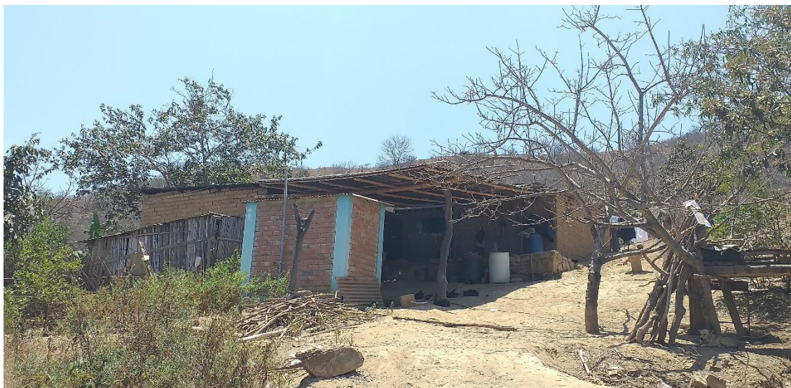
Figura 22. Fotografía de la vivienda N°02.
