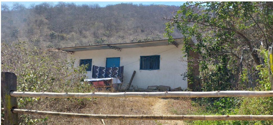
Figura 28. Fotografía de la vivienda N°04.
