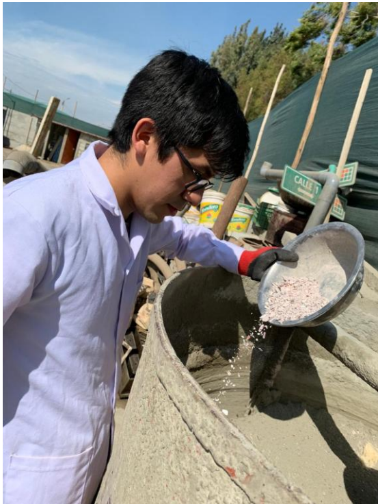
Fig. 117. Vertido de materiales en la olla mezcladora.
