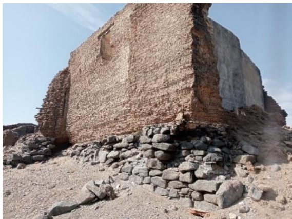
SOBRECIMIENTO DE PIEDRA Y MUROS DE ADOBE
