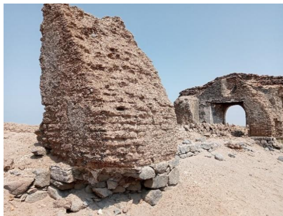
COLUMNA DE ADOBE
