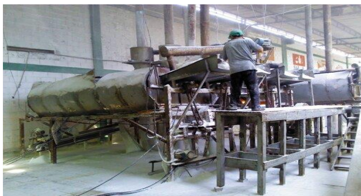
Figura N° 32. Estado actual de hornos de la empresa KAR & MA SAC.
