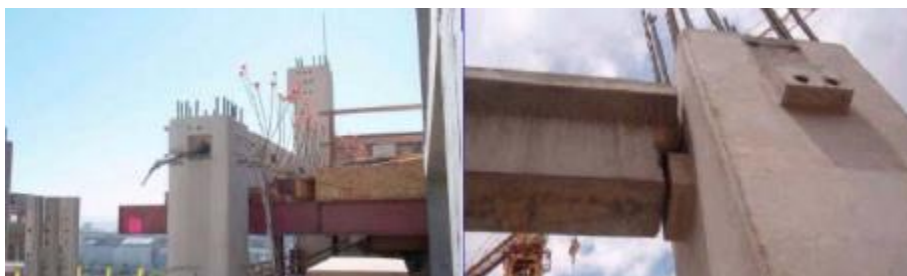
Fig. 22 Conexión viga – columna, postensado
