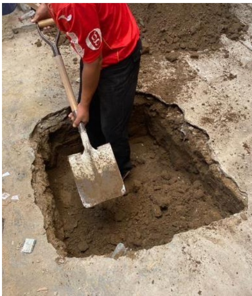
Fotografía 6. Excavación de calicata de 1m x 1m
