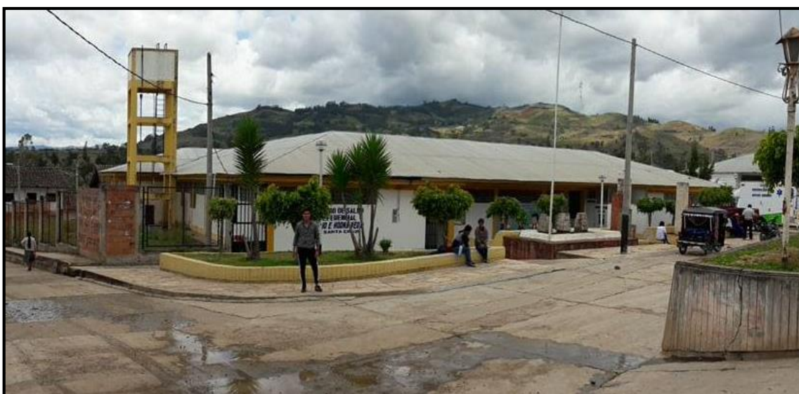
Fotografía N°: 11 Centro de Salud santa cruz
