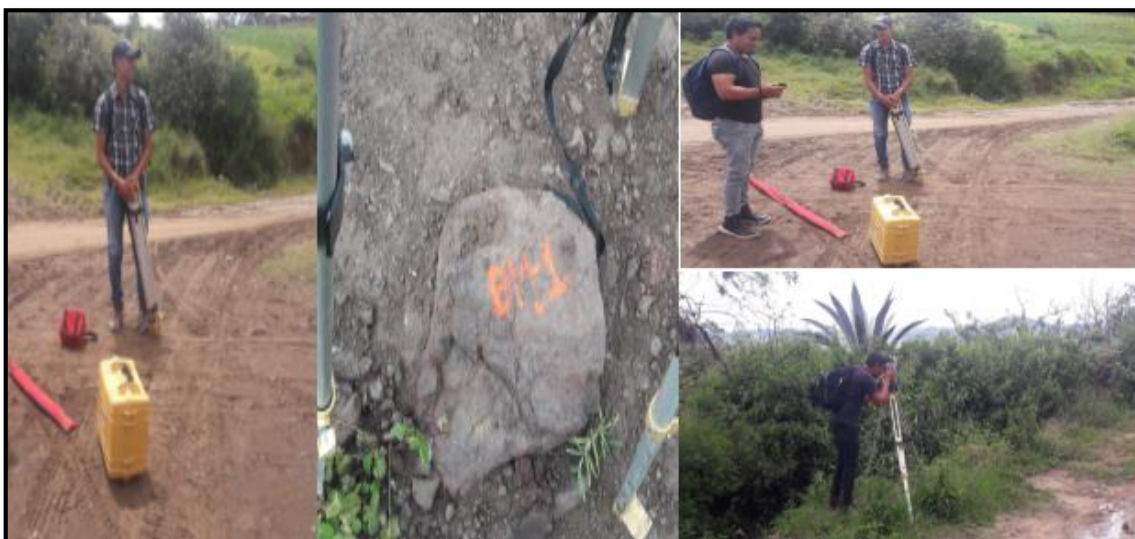
Fotografía N°: 3 Punto de Partida del Levantamiento topográfico
